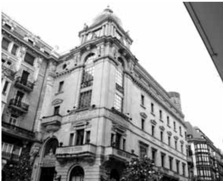
Edificio central del Banco Guipuzcoano en Donostia. FOTO: AINARA GARCIA
